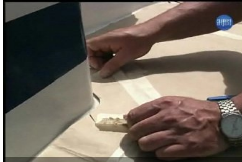
Abbildung 5: Aufkleben einzelner Rundungen
