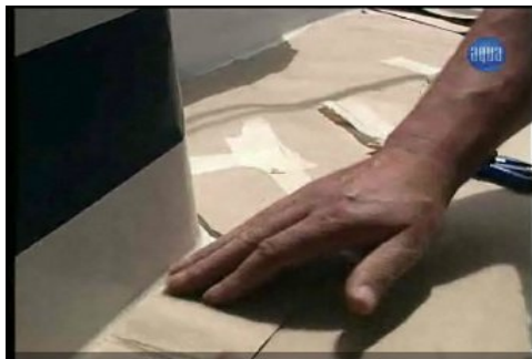
Abbildung 3: Zurückschlagen und Fixieren des überstehenden Randes
